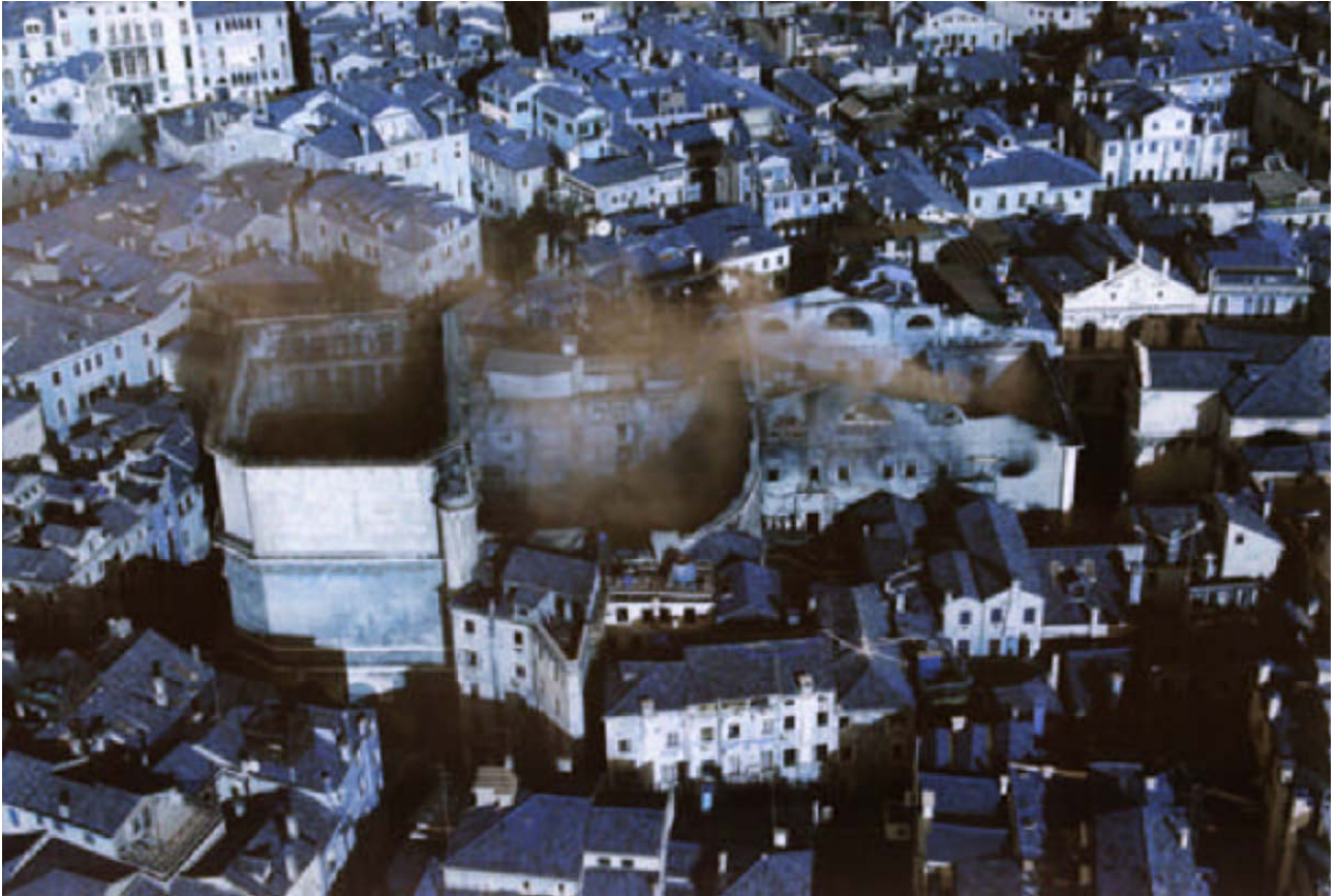
Situazione ad incendio spento, con il crollo di tutte le coperture e soffitti
