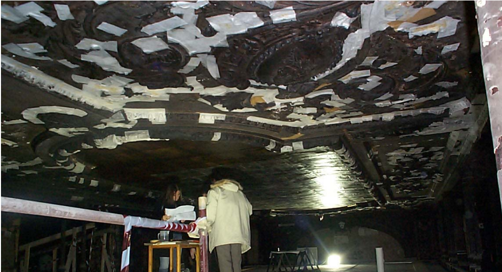
Velinatura e messa in sicurezza del soffitto e della tela dell'Armenise
