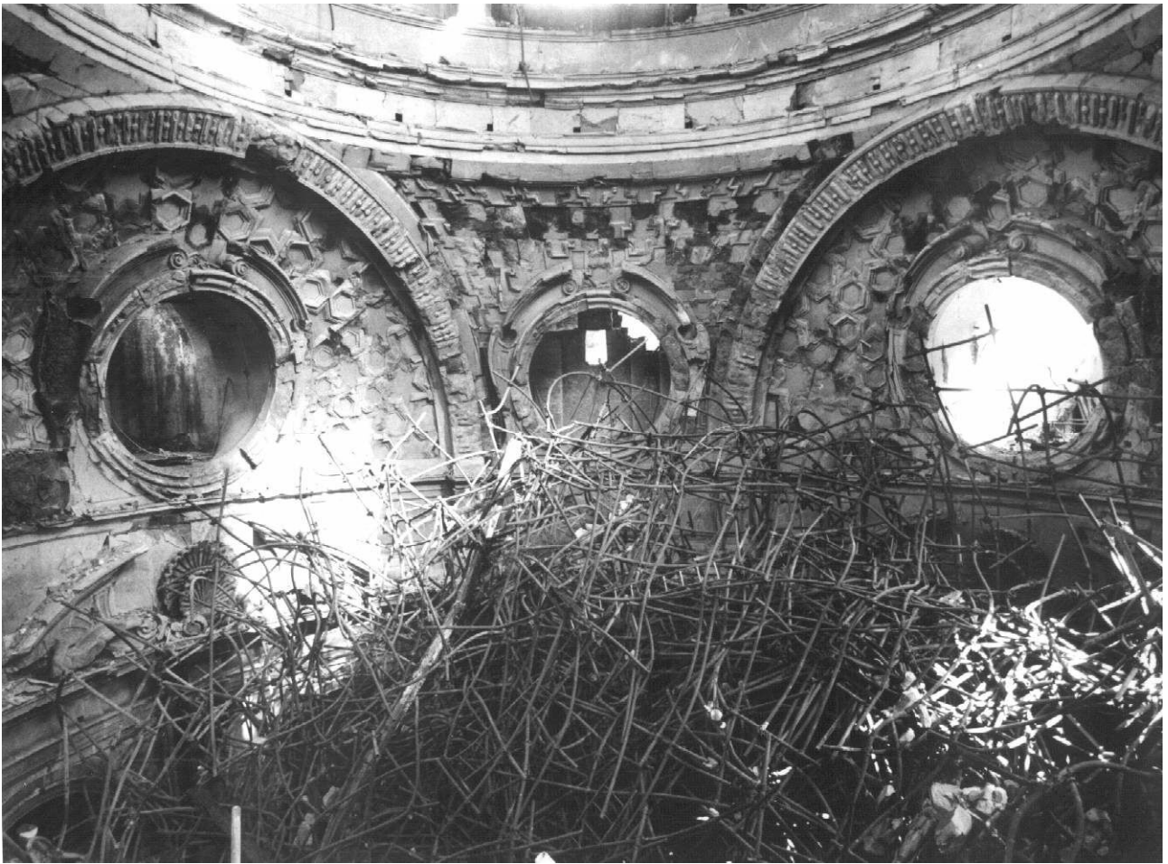
La cappella dopo l'incendio
